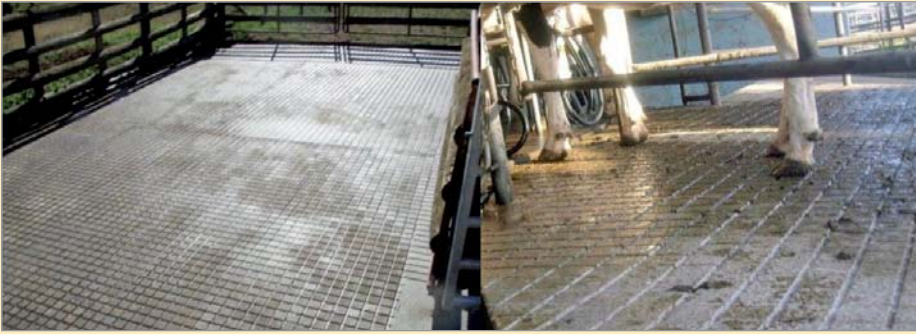
Рис. 1. Продольная и поперечная насечка с узкими канавками
