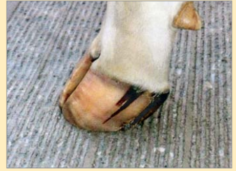
Рис. 2. Продольная насечка с узкими и частыми канавками
