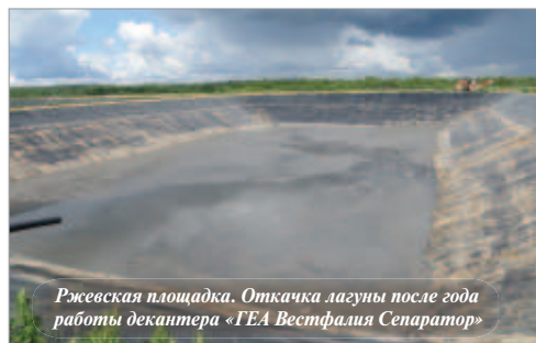
Откачка лагуны после работы шнекового пресса. Глубина лагуны — 6 м
