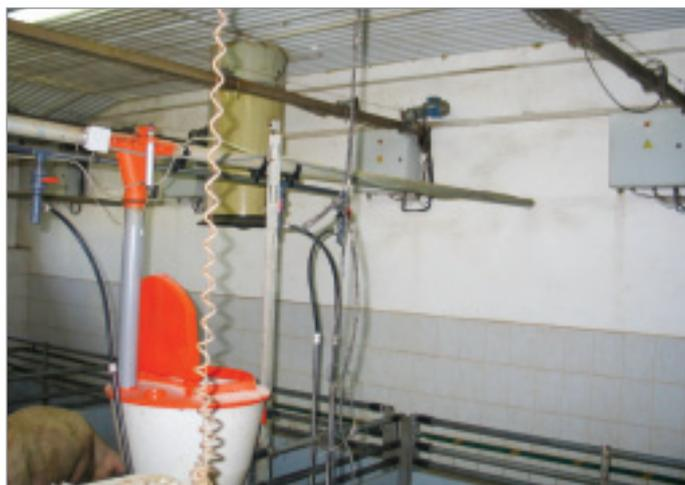
**Фото 2.** Расположение блоков силового управления и системы мобильного подвеса ИК-излучателей в секции доращивания поросят-отъемышей
