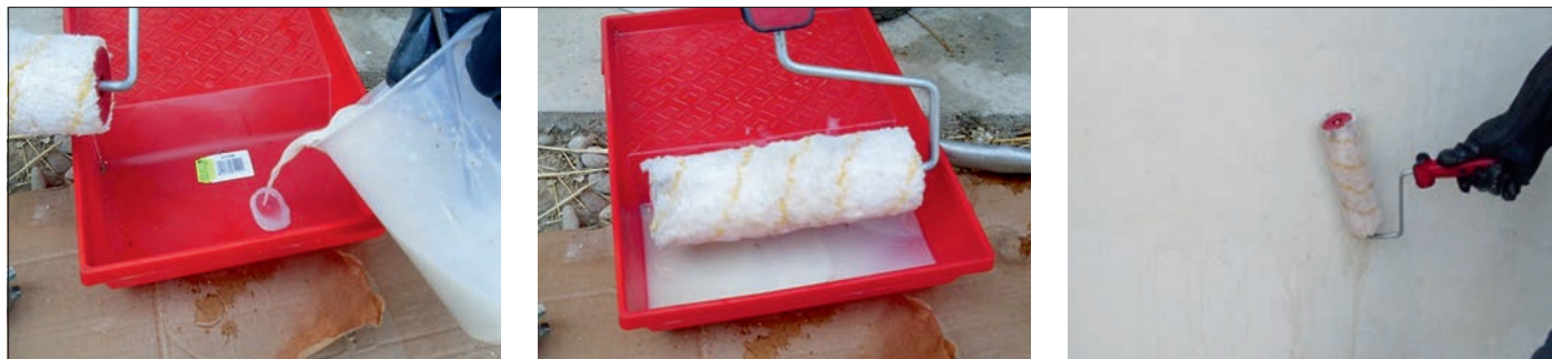
Фото 10–12. Нанесение препарата Фугита при помощи валика (покраска)
