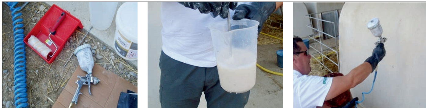
Фото 7–9. Нанесение препарата Фугита методом пульверизации
